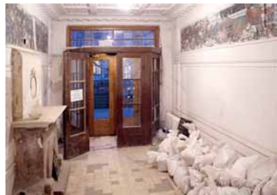
Ремонтные работы в многоквартирном доме в центре города.
