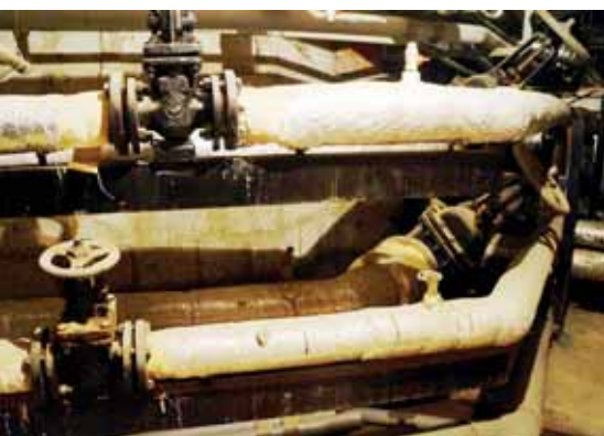
Подготовка внутридомовых теплосетей к отопительному сезону.
